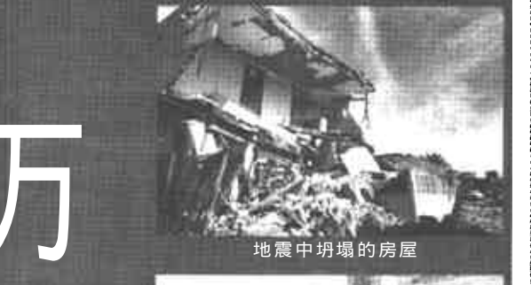
地震中坍塌的房屋
